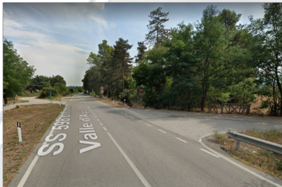
Interventi sugli accessi a raso
