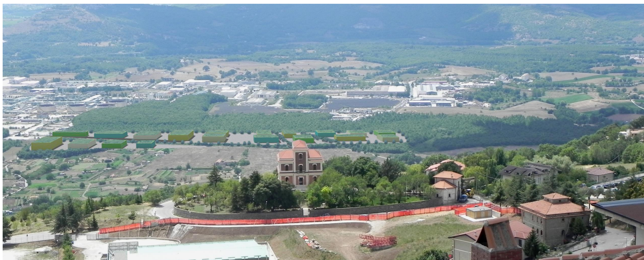
Figura 48 – Punto di ripresa dall’abitato di Viggiano (POV3), fotoinserimento PdL. E’ possibile osservare come l’adozione di uno specifico piano colore generi un impatto visivo molto limitato. (Confronto pre e post operam)
