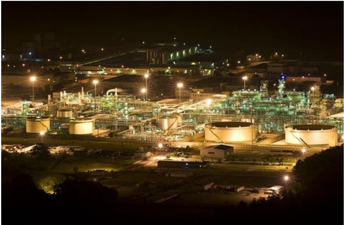
Figura 53 – Veduta notturna dell’area ASI Val d’Agri con particolare riferimento al COVA
