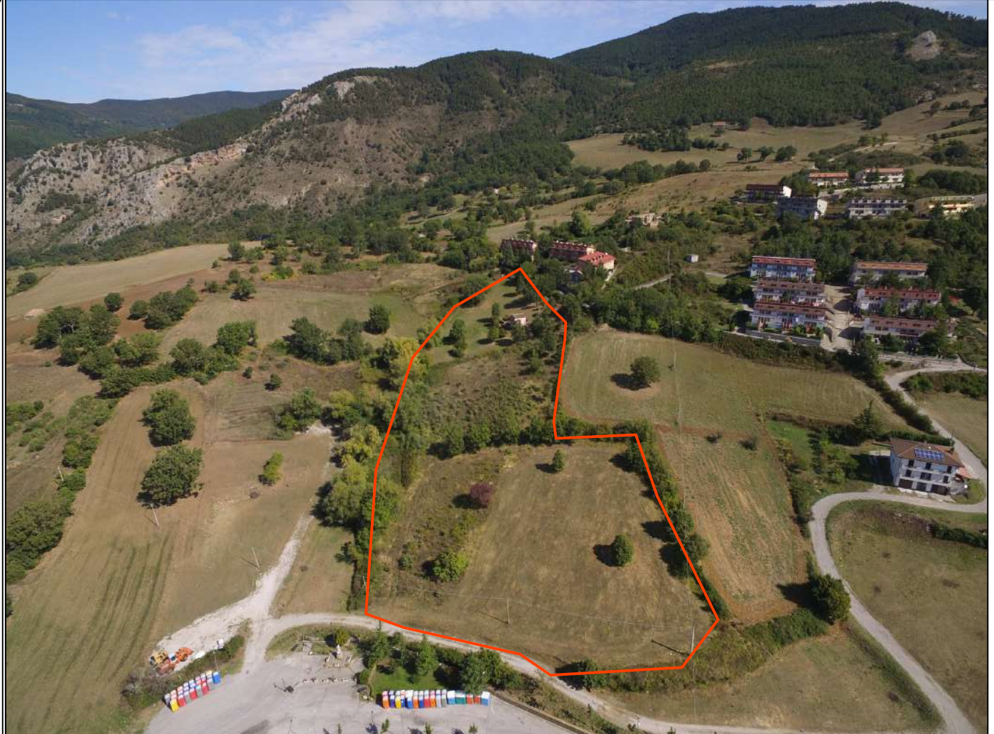
Area di lottizzazione - foto aerea
